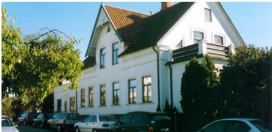
Hörnhuset Apoteksgatan 10, Limhamn vid hörnet Apoteksgatan/Östra Bernadottsgatan.
