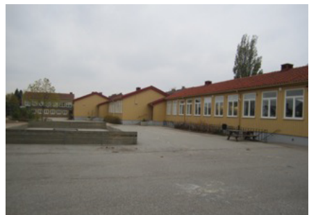
Geijerskolan före rivning
