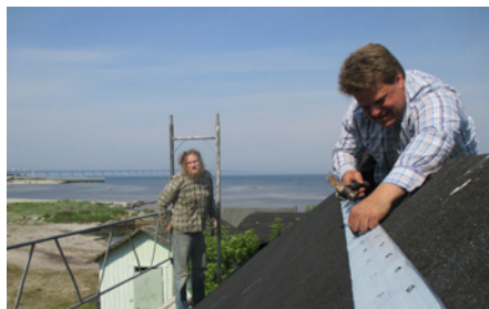
Renovering av tak.
