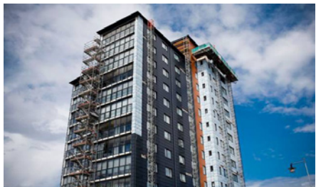
Källa Lokaltidningen Malmö/Limhamn: Höghus på Ön får ny fasad - den gamla blåste ner. 14-våningshuset på Sundholmogatan på Ön stod klart så sent som för fyra år sedan. Nu håller hela den stora fasaden på att bytas ut. Orsaken är att de för huset karakteristiska svart och orange plåtarna inte suttit fast ordentligt i fasaden.
