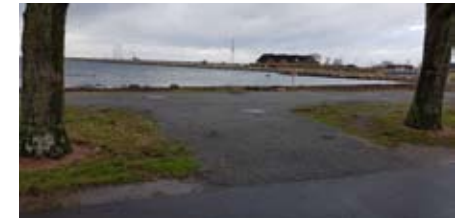
VA SYD:s grusväg med brunnlock. Bild Tina N Mörnstam
