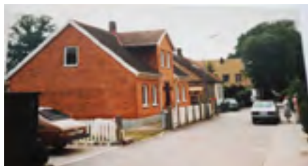
Detta är huset på Carl Johansgatan 49 efter ombyggnad nr 1.
