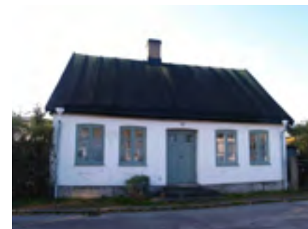
Första Bevarandepriset år 1984 gick till det vita lilla huset med blåmålade fönster och dörrar på Tycho Brahegatan 15.
