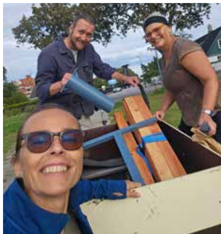
Reparation av bord
